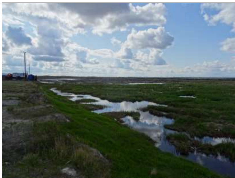
Рисунок 2.2-3. Подтопленные участки вдоль уступа насыпи в районе ПНОБ-6
